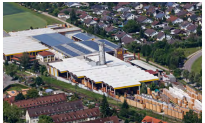
Dillingen a. d. Donau • Hobelwerk • 43.000 m 2 größtenteils überdachte Lagerfläche
