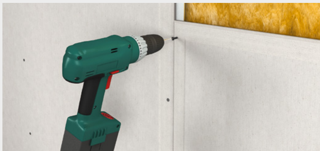
Schrauben auf Stahl-Unterkonstruktion
