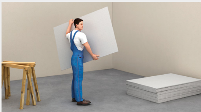
Einzelne fermacell® Gipsfaserplatten hochkant tragen
