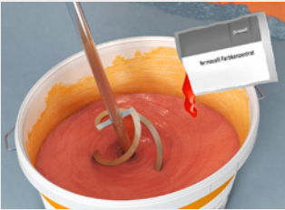
Abb. 7: 2. Auftrag: Farbkonzentrat zur Restmenge der Flüssigfolie geben und homogen einrühren. Eingefärbte Flüssigfolie satt auftragen. Weitere Informationen sind im Produktdatenblatt zu finden.
