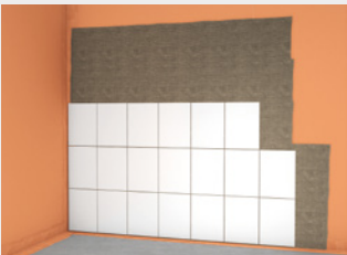
Abb. 8: Verfliesung mit fermacell™ Flexkleber im Dünnbettverfahren auf vollflächiger Abdichtung
