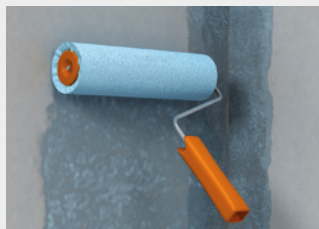
Abb. 1: Vollflächiges Aufbringen des fermacell™ Tiefengrunds – Trocknungszeit mind. 2 Stunden – Mischungsverhältnis: 1:1 bis 1:2 mit Wasser
