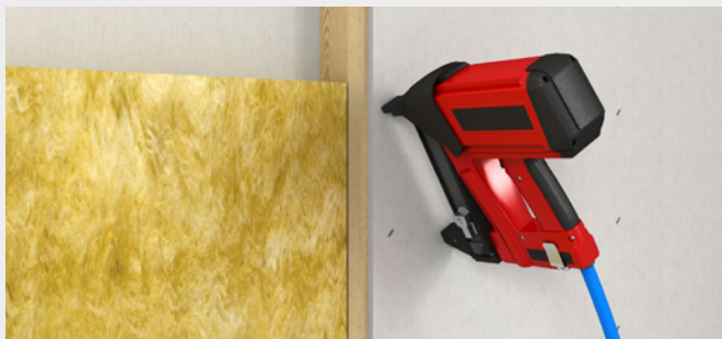
Klammern auf Holz-Unterkonstruktion
